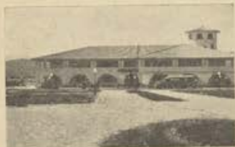
O pavilhão do Comando
