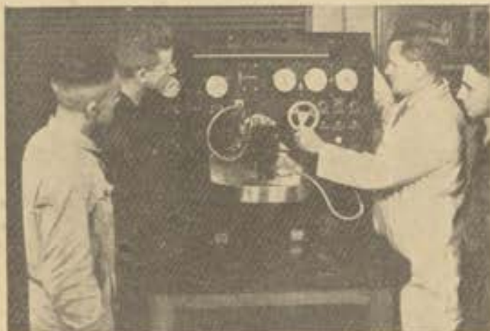
No dept. de Hélices, ao observarem um aparelho atestador do governador, vemos os alunos: (à esq.) Arango (788) e Gomes (839) e (à dir.) Nascimento (838), sob a orientação de Mr. Schipper.
