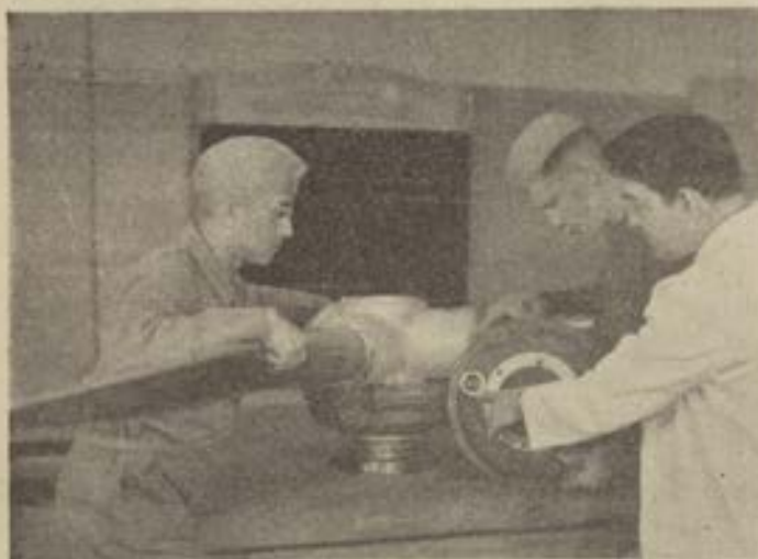
O Instrutor Sr. Scott, mostra aos seus alunos o "aeroprop" da hélice.
