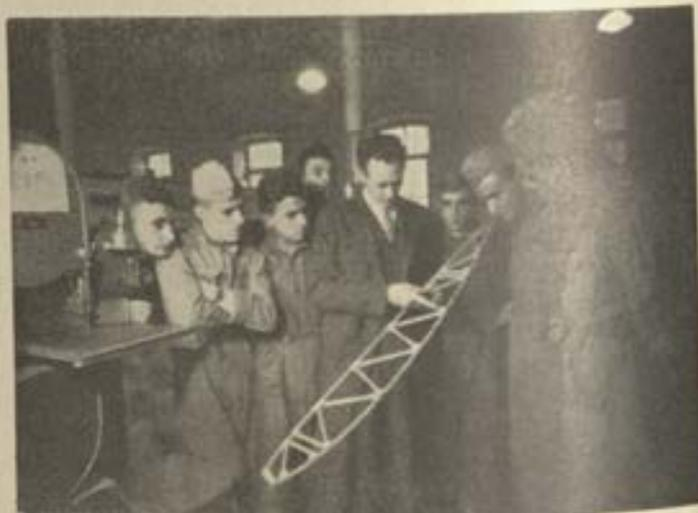
Vemos acima o instrutor Goecke explicando a construção das nervuras da estrutura usada em aviões leves, aos alunos:
